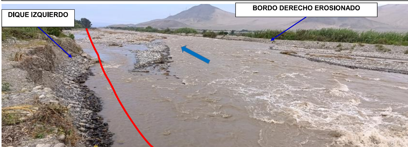
FIGURA N°03: RIO CHANCAY HUARAL, MARGEN IZQUIERDA Y DERECHA SE ENCUENTRA PASAMAYO BAJO Y LUNAVILCA RESPECTIVAMENTE, CON DIQUES DE AMBAS MARGENES MUY EROSIONADOS Y CON EL CAUCE COLMATADO.
