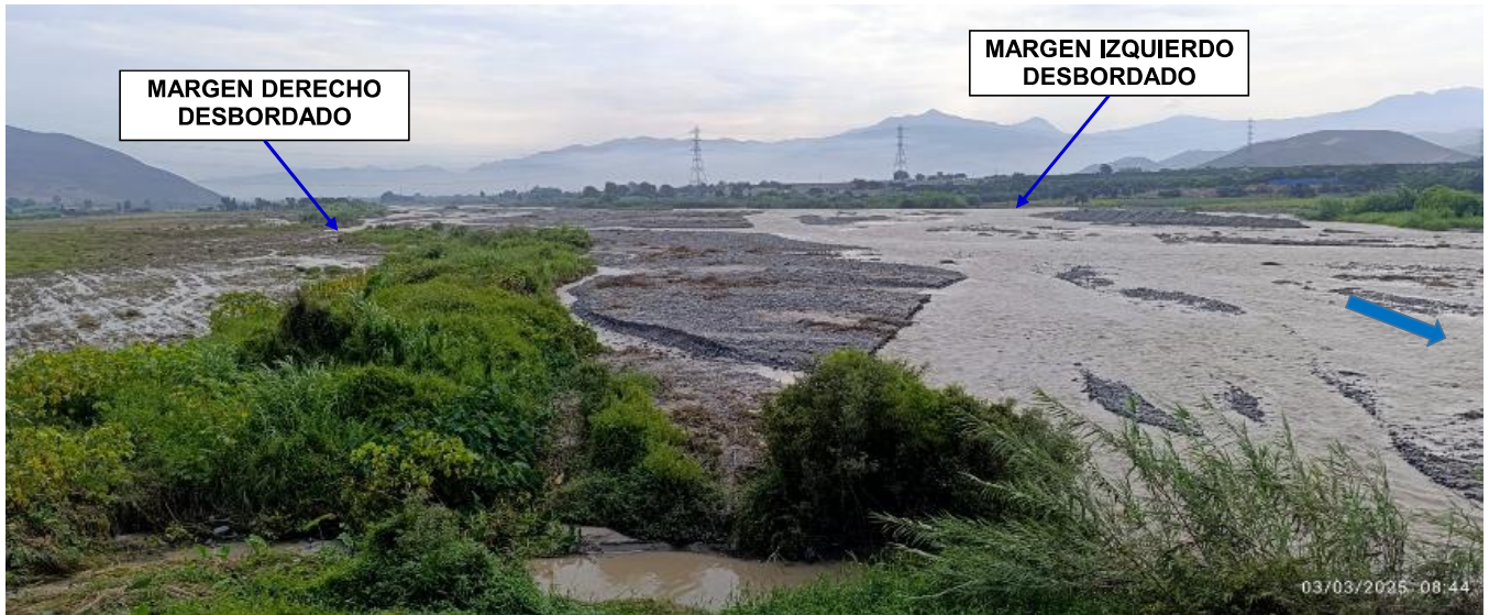
FIGURA N°04: IMAGEN PANORAMICO DEL RIO CHANCAY HUARAL, CON ACUMULACIÓN DE SEDIMENTOS QUE OBSTRUYEN EL CAUCE, DISMINUYENDO SU PROFUNDIDAD Y CAPACIDAD DE CONDUCCIÓN HÍDRICA CON LA DEGRADACIÓN INTENSA DE LOS DIQUES Y CONSECUENTE DESBORDE HACIA AMBAS MARGENES.
