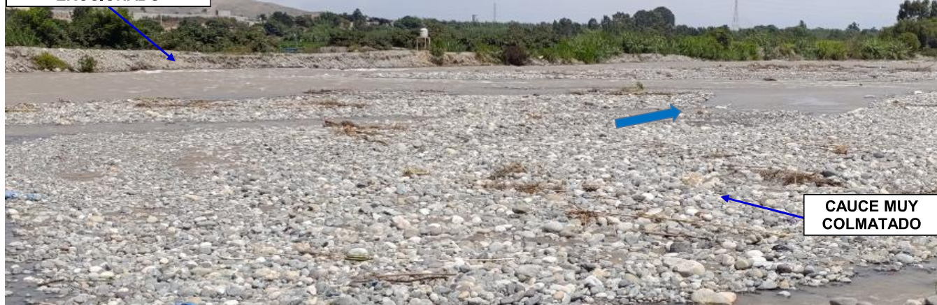
FIGURA N°01: RÍO CHANCAY HUARAL, AGUAS ABAJO DE LA BOCATOMA PASAMAYO BAJO CON DIQUES DE AMBAS MARGENES MUY EROSIONADOS Y EL CAUCE COMPLETAMENTE COLMATADO CON EL CAUDAL DIVIDIDO HACIA LAS MARGENES.
